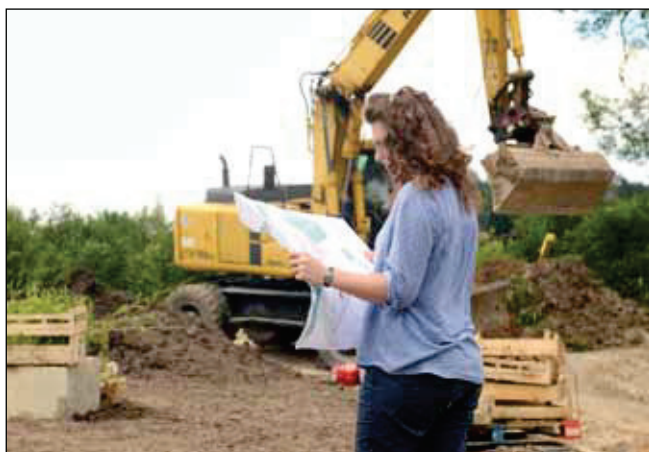
Wie aus ihren Ideen Realität wird, kann die Landschaftsarchitektin bei ihren Baustellenbesuchen nachverfolgen.
