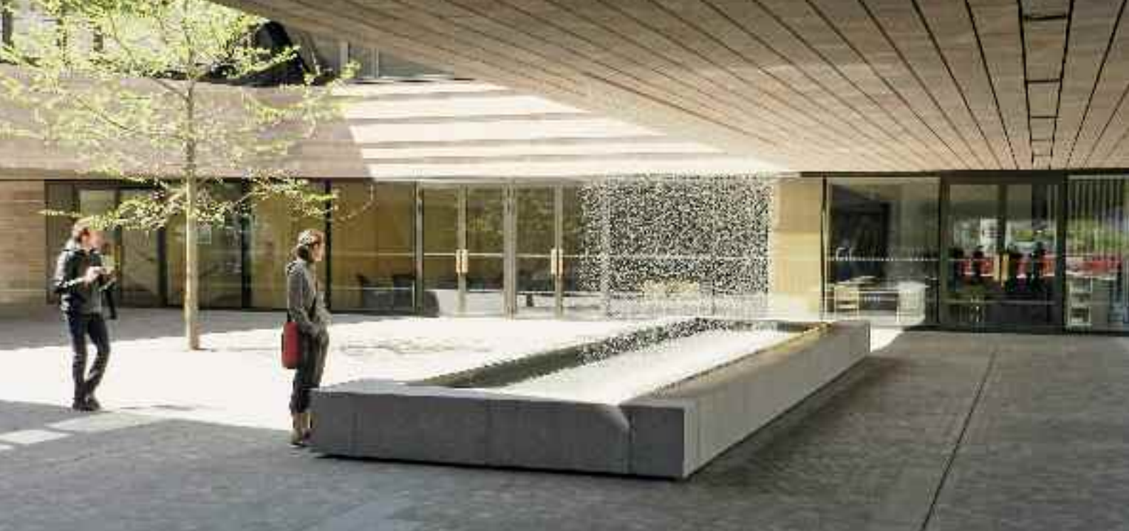
Brunnen mit akustisch wirksamem Wasservorhang.
