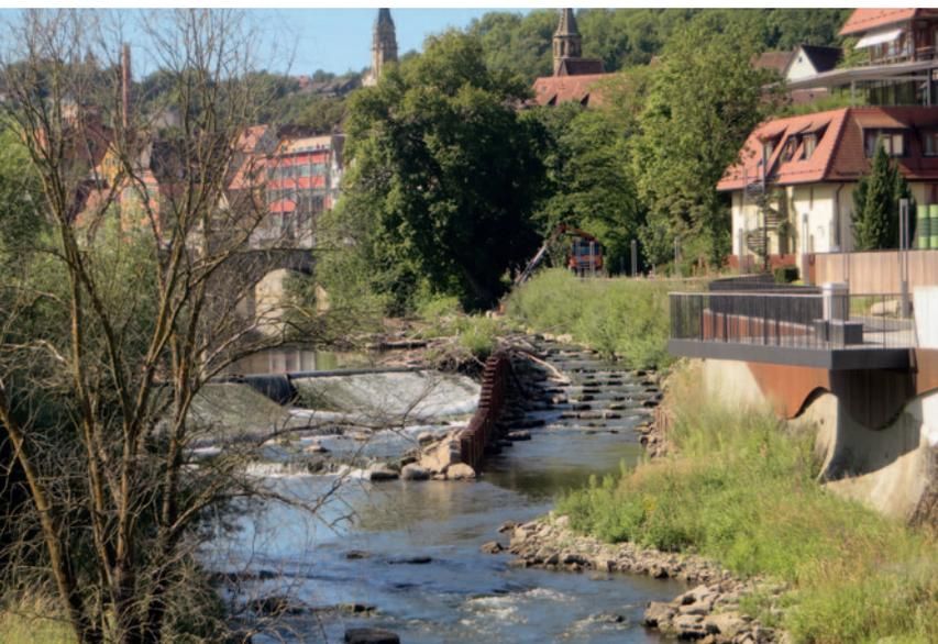
Die Fischtreppe verbindet das Oberwasser des Dreimühlenwehres mit dem Unterwasser. Die bestehende, im Bestand teils sehr unansehnliche Ufermauer wurde mit einer wellenartig geschwungenen Stahlverkleidung optisch aufgewertet und spiegelt so die Bewegung des Wassers in den angrenzenden Freiraum.
