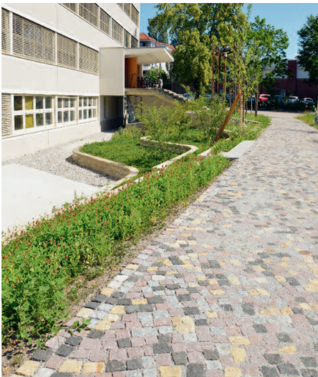
Buntes Mosaiksteinpflaster dient als Wegeverbindung zwischen dem Haupteingang des Schulbaus und dem Hortgebäude.
