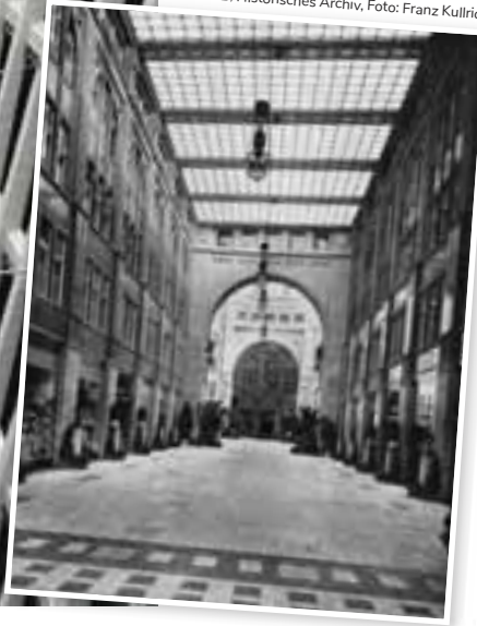
Das von Franz Ahrens in 15 Monaten von 1907 bis 1908 errichtete Gebäude wurde 1909 als Fried- richstraßenpassage eröffnet und war nach der Kaiserpassage Unter den Linden die zweitgrößte Einkaufs- passage der Stadt.
