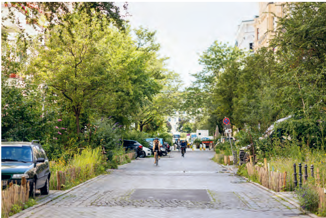
Im Berliner Gräfekiez hat der Bezirk Gehwege und Straßen saniert. In der Folge kann Regenwasser großflächig versickern, sind Straßen und Bürgersteige bei Starkregen besser vor Überschwemmungen geschützt. Bäume, Sträucher und Wiesen sorgen nach Ansicht von Felix Weisbrich, Leiter des Straßen- und Grünflächenamtes Friedrichshain-Kreuzberg, für saubere Luft und bei Hitze für Abkühlung. © Regenwasseragentur/Ahnen & Enkel / Silke Reents.
