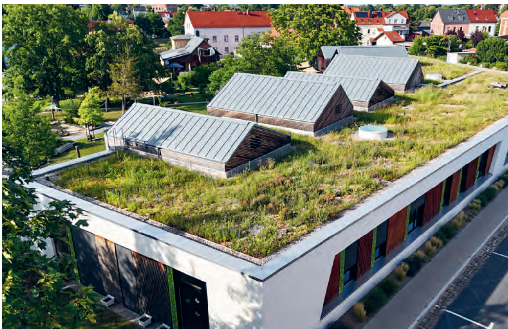
Biodiversitätsdach der Kita Großenhain. Planung: Blaurock Landschaftsarchitektur, Dresden. Ausführung/Pflege: HEIDEL Dachbegrünung GmbH. © HEIDEL Dachbegrünung GmbH
