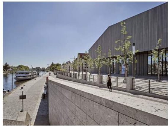
Eine Rampe schafft die Verbindung von der Promenade zur Lände.
