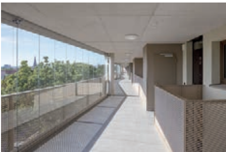
Ansicht der verglasten Laubengänge mit Blickrichtung Fetscherplatz © Till Schuster
