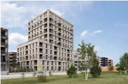
Ansicht SüdWest © Stephan Baumann
