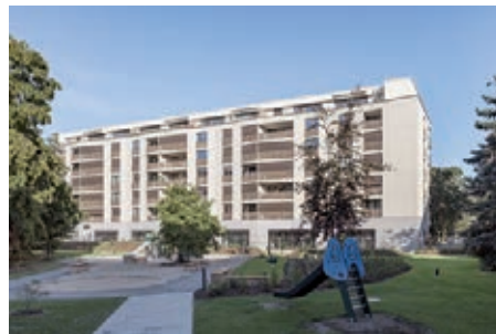
Außenanlagen im Innenhof des Wohnquartiers © Till Schuster
