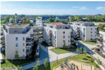
Gebäudefinger mit Lärmschutzloggien © Martin Gaissert
