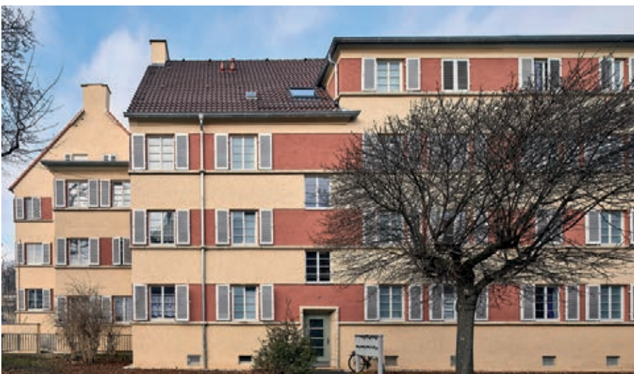
Denkmalgerecht saniert. © Friedemann Rieker
