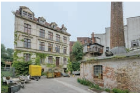
Zustand vor dem Umbau © Jann Höfer
