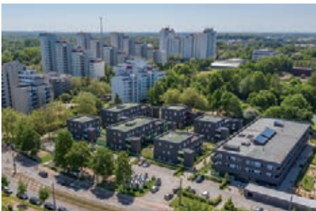
Luftbild von Norden - Mikroquartier auf Rückbaufläche ehemaliger Hochhäuser © GEWOBA, Fotograf Christian Haase
