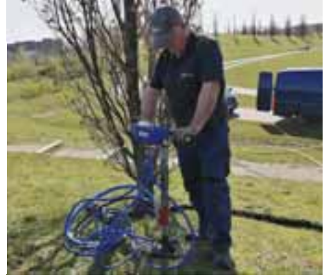
Druckluftlanzenanierung im Krupp-Park in Essen.
