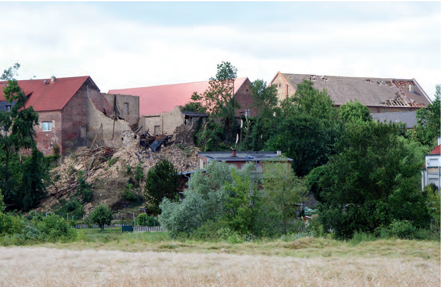
Mit Spitzengeschwindigkeiten von über 140 km/h richtete am 07.07.2015 ein Downburst (Fallböe) im Nordwesten von Halle im Ortsteil Lettin große Schäden an einer Stallung an.
